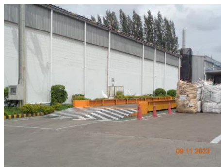
ภาพที่ 2.2-19 จุดขนถ่ายน้ำหนักรถบรรทุก
