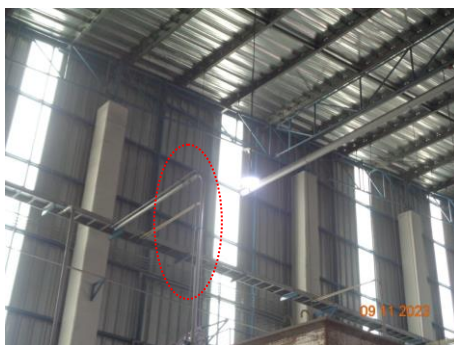
ภาพที่ 2.2-34 การติดตั้งระบบป้องกันไฟฟ้าสถิต
