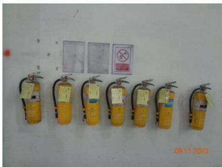
ภาพที่ 2.2-32 ถังดับเพลิง Class D บริเวณภายในอาคารบดตะกั่ว
