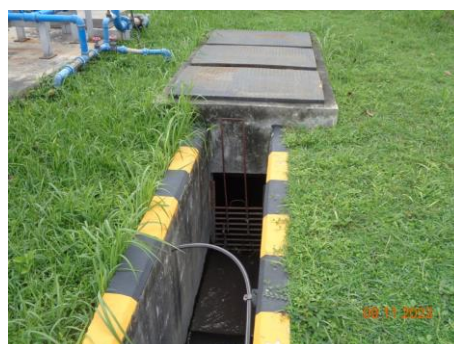
ภาพที่ 2.2-11 บ่อรวบรวมน้ำเสีย (Sump Pit)
